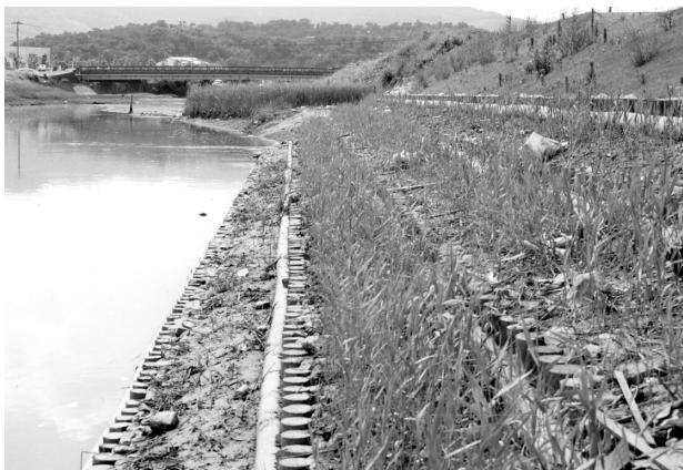
図11. 不知火海北部大野川右岸の階段状護岸、階段状にして、現地の泥を盛り、アイアシ *Phacelurus latifolius* を植栽し、塩生湿地の生物の生息に配慮した(熊本県による設計・施工). 2001年6月16日, 吉崎撮影.
