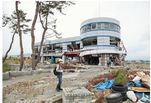
図3. 気仙沼市岩井崎プロムナードセンター建物正面被害状況（2011年5月21日撮影）。
