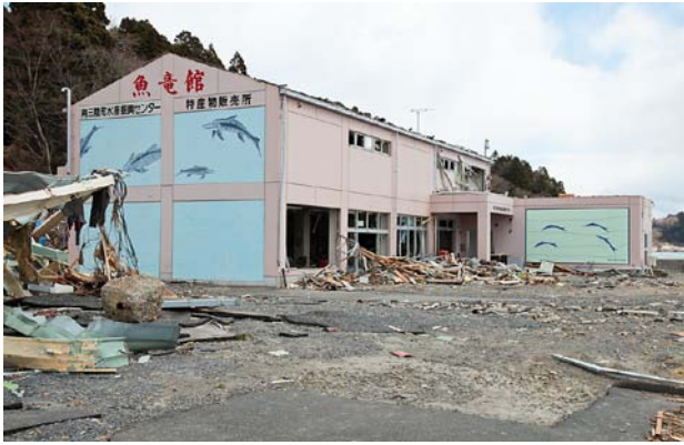
図4. 南三陸町歌津魚竜館（水産振興センター）建物正面被害状況（2011年4月4日撮影）。
