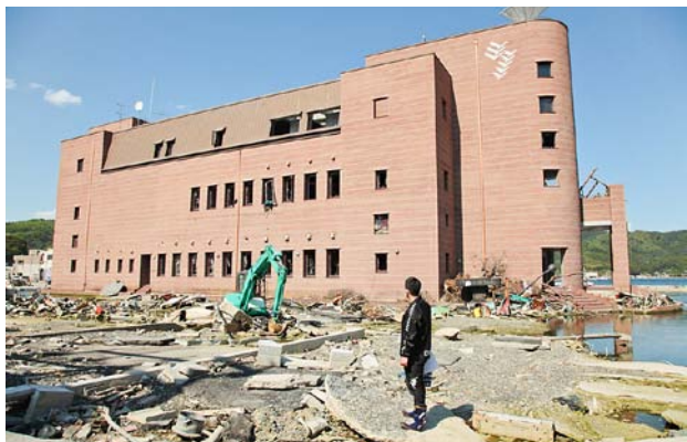
図7. 女川町マリナル女川建物市街地側被害状況（2011年5月18日撮影）。
