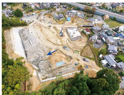
図1. 工事現場の航空写真。工事現場（中央付近の緯度と経度はそれぞれ北緯35°22'31", 東経137°15'09", 敷地面積は17178.8m 2 ）の北西斜め上空からドローン（Phantom4 FC330, DJI社製）により撮影。青矢印は図2の撮影方向。
